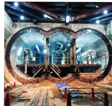
地下鉄の建設（3 連シールド工法）
